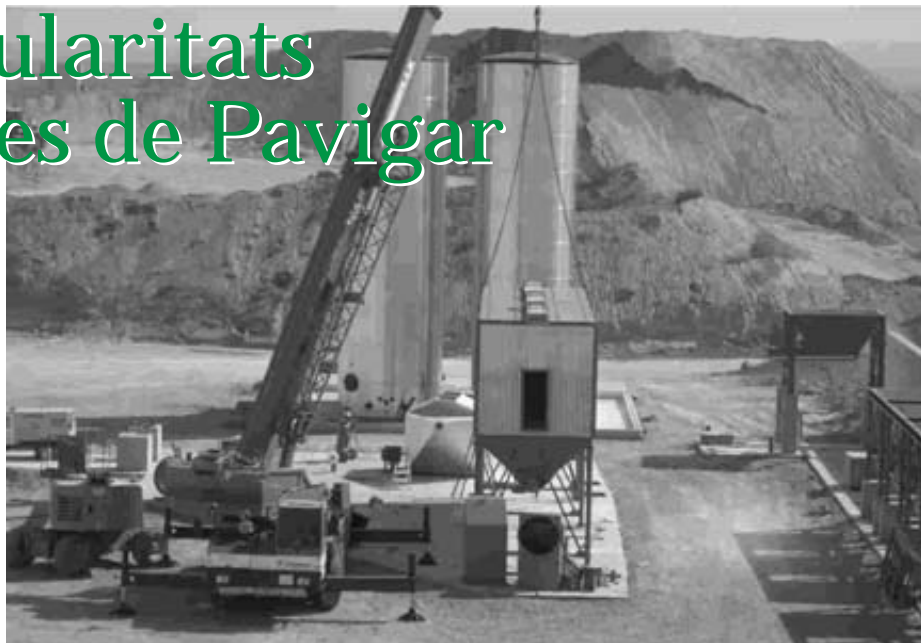
Vista de les obres realitzades fins a data 14 de gener de 2008 al Polígon 503, Parcel·la 21, de Torrelameu, per Pavimentos Gar SA, sense comptar amb les autoritzacions obligatòries.
